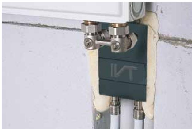
Подключение отопительных приборов из стены.
