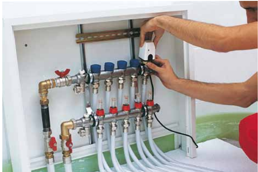
Установка сервоприводов PRINETO
